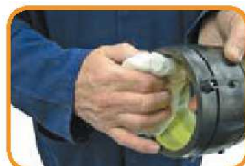
アセトンで湿した布で溶接ソ ケットを拭く
