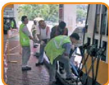
UPP と交換するため古いパイプを除去
