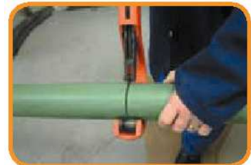
UPP カッターでセカンダリパイプを切断
