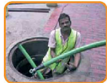
UPP パイプをダクトに導入する
