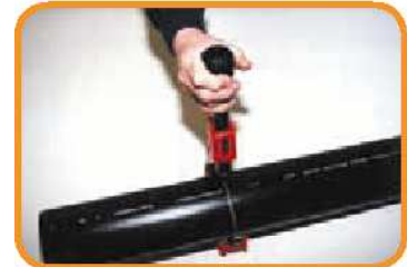
UPP カッターでプライマリパイプを切断
