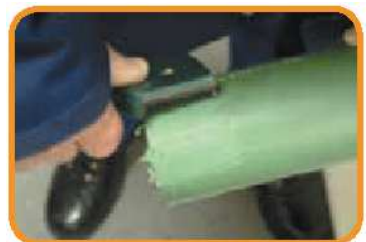
ハンドスクレーパで UPP セカンダリパイプをすり合わせ
