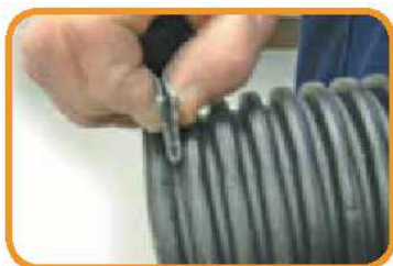
ダクトの波形部を全部研磨
