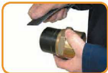
エメリー布で UPP 非エレクト ロフュージョン継手を研磨
