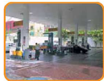
施設の運転中でもパイプの交換作業は続く
