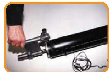
スクレーパで UPP プライマリパイプをすり合わせ
