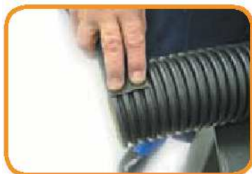
ダクトパイプをエメリー布で 研磨
